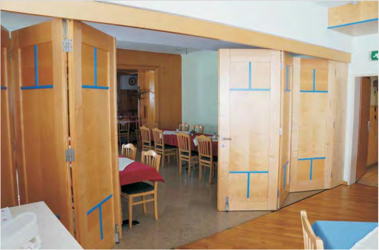
Falttoranlage 2x3 flügelig mit im Boden versenkter U-Profilführung. Deckenmuffe und Tragwinkel Typ C. Doppelpaarige Rollapparate; Gehtüre
