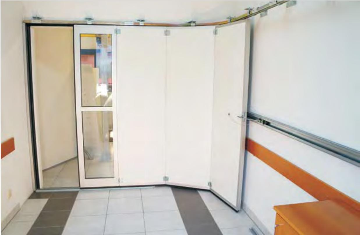
Seitensektionstor mit Doppelaufschiene mit platzsparendem seitlichem Einlauf.
