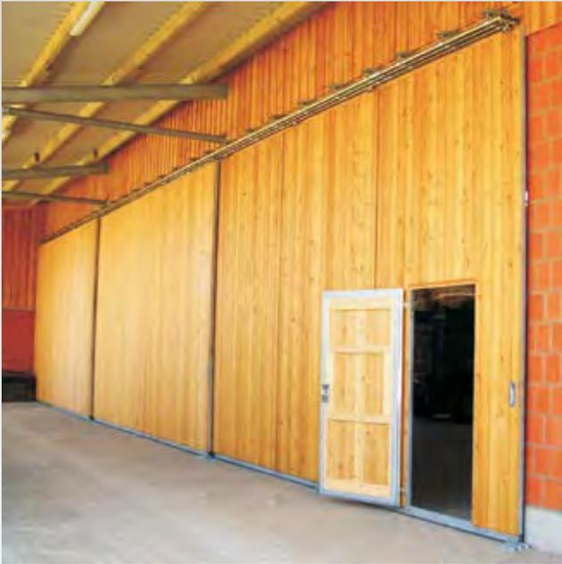
Mehrflügelige Toranlage mit verstellbaren Wandwinkeln für 3 Laufschiene, mit höhenverstellbaren Muffen und doppelpaarigen Rollapparaten, Gektüre integriert.
